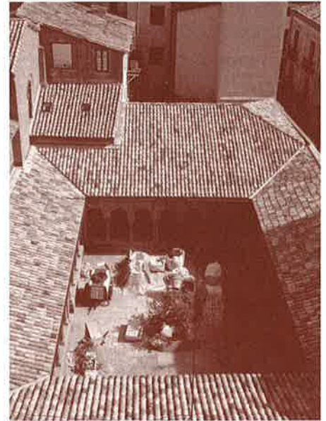
Visión aérea del claustro, con signos de que prosiguen las obras. Foto: Tinazoom
